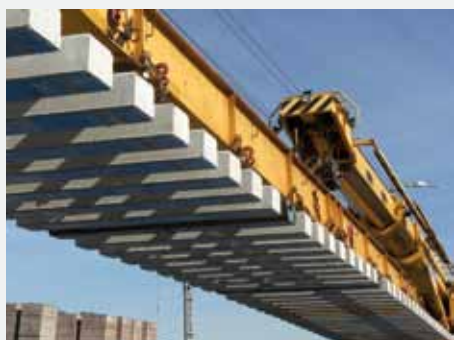
Монтажный поезд с под- шпальными прокладками для стрелочных переводов
